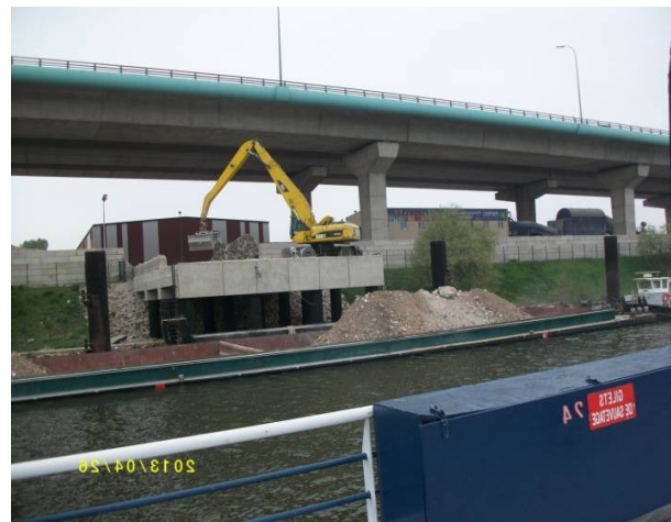
On stocke les gravats sous l'autoroute
