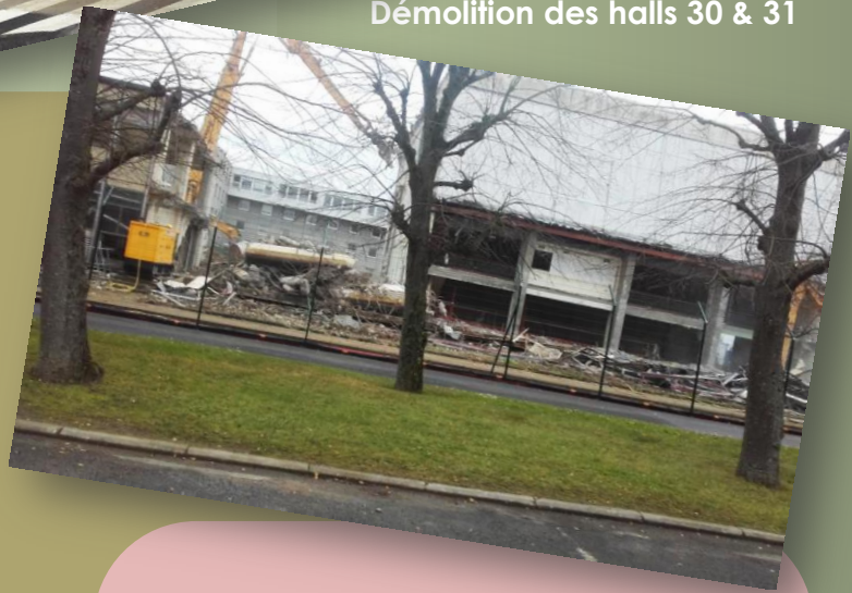
Démolition des halls 30 & 31
